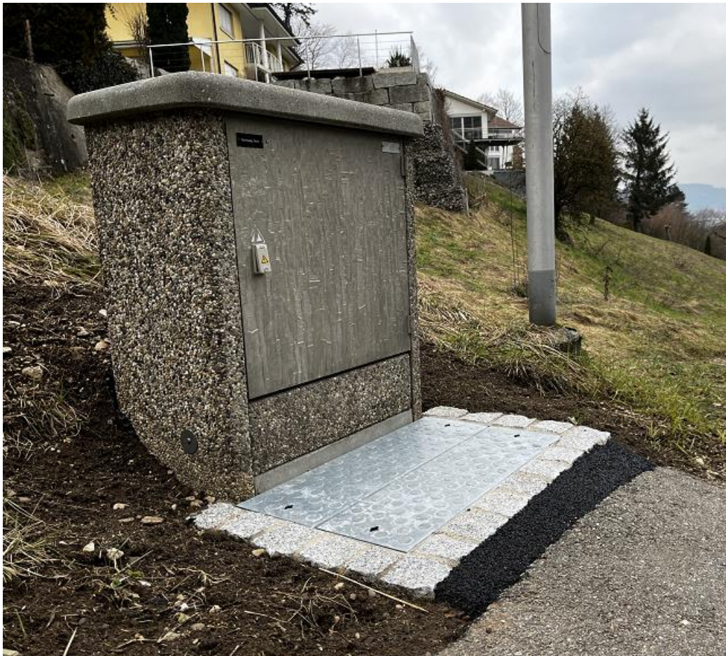
Sanierte Verteilkabine Buchsweg Nord mit neuem Vorschacht
