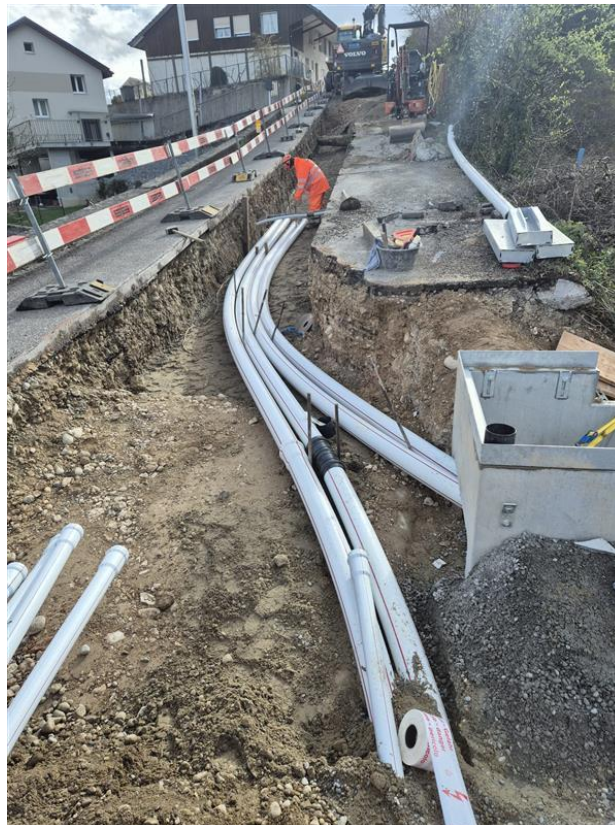
Verkleitungsbau an der Krähenbühlstrasse
